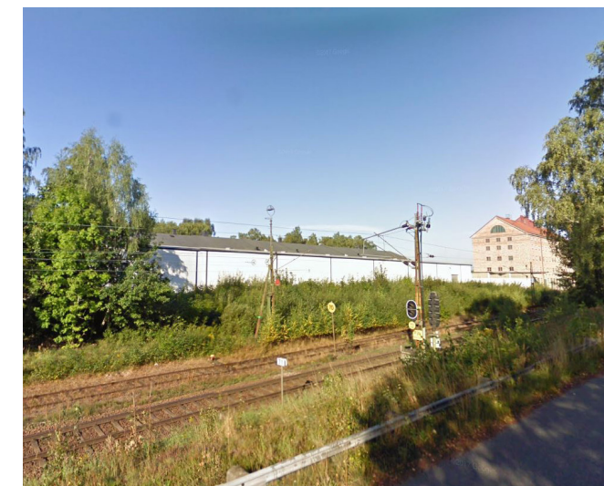
DEN ÖSTRA FASADEN LIGGER MOT JÄRNVÄGEN
