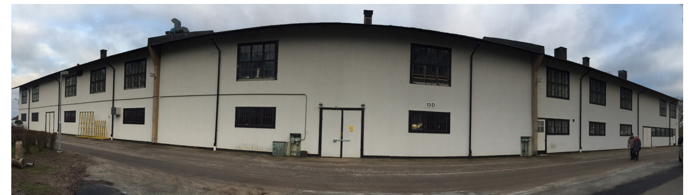
PANORAMAFOTO AV BEFINTLIG FASAD MOT VÄST
